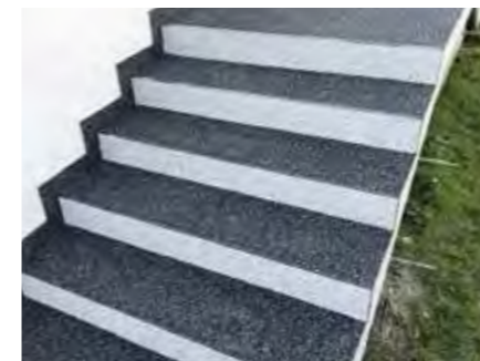
Außentreppe abgedichtet und mit Marmorkies beschichtet
