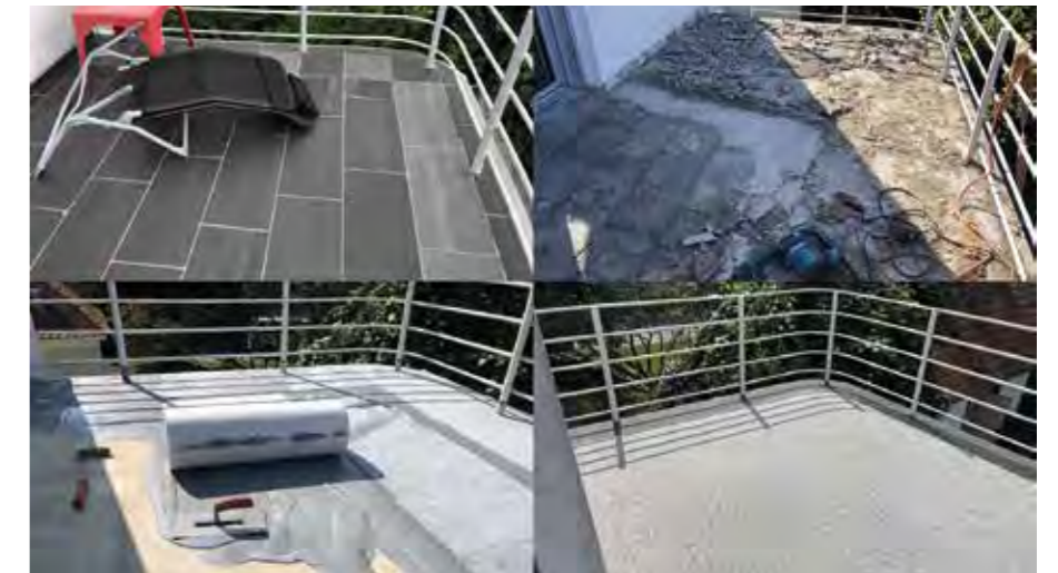
Sanierung einer Dachterrasse mit Bauwerksabdichtung und Beschichtung (vorher-nachher)
