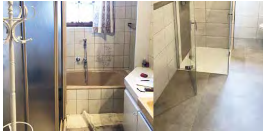
Badsanierung in Ebersdorf (vorher-nachher)
