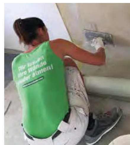
Kalk-, Lehm- und Klimaputz
