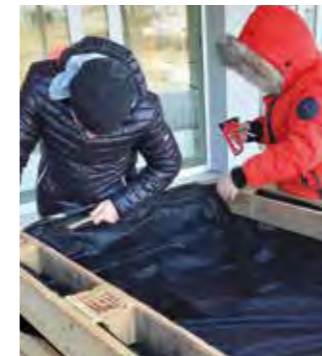
Hochbeet wird gebaut.
