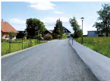
Die Straße mit neuem Gehsteig und neuer Straßenbeleuchtung
