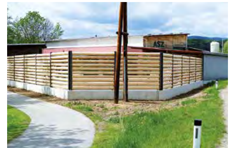
Der Lagerplatz für Baum- und Strauchschnitte wurde neu errichtet.
