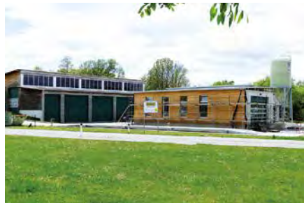
Die Bauhof-Erweiterung steht kurz vor der Fertigstellung.
