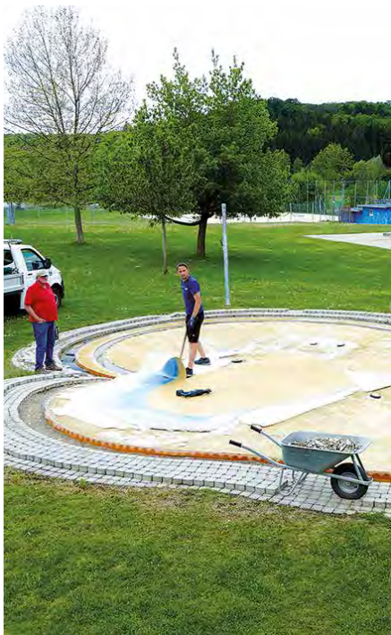
Das Planschbecken des Freibades Kaindorf wurde generalsaniert.
