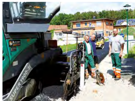
Die Arbeiter der Firma Klöcher-Bau beim Asphaltieren der Schloßbergstraße
