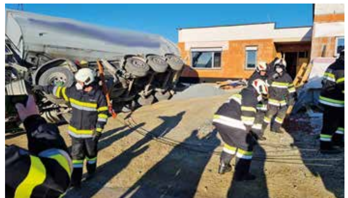
Beim Abladen von Schotter stürzt in Dienersdorf ein LKW-Sattelzug um: Bergen mit Seilwinde und Bagger.
