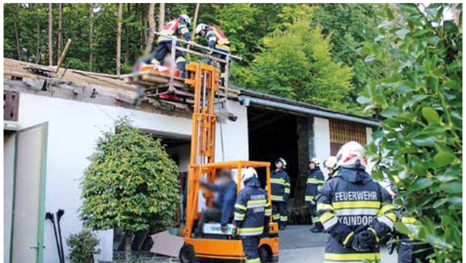
In Hofkirchen verletzt sich bei Dacharbeiten ein junger Mann schwer am Bein: Erstversorgung am Dach und gesicherte Rettung
