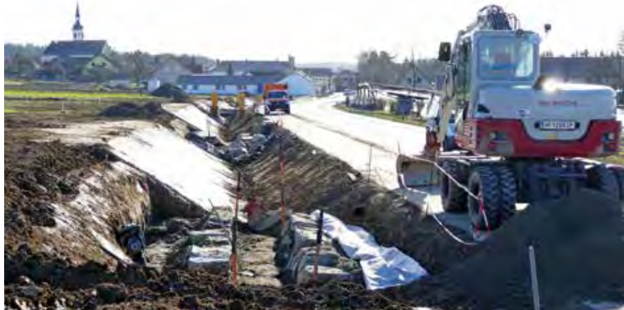
Die Hangwassermaßnahmen an der L 413 werden derzeit umgesetzt.
