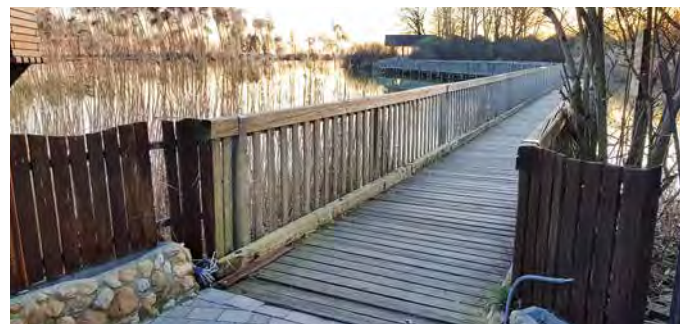
Die lange Steg wird neu errichtet
